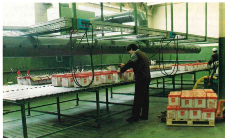
Idóneas instalaciones que permiten una cómoda manipulación de acumuladores.
