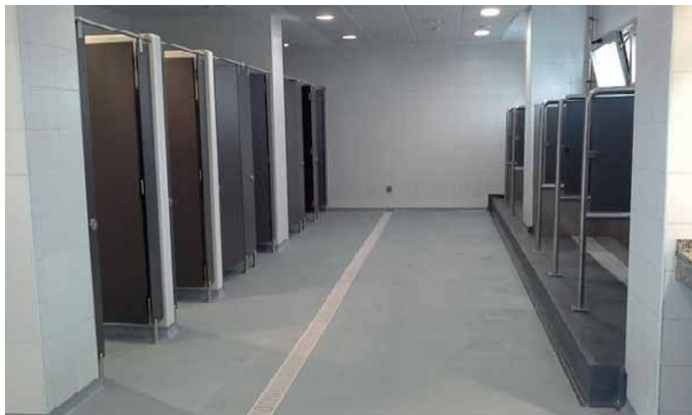
Renovació dels lavabos de la T1
